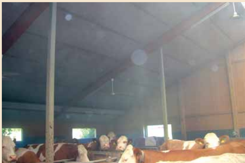
Bild 3: Die Deckenventilatoren sorgen für eine optimale Luftumwälzung.
