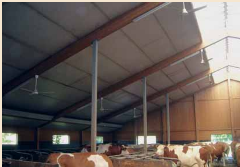
Bild 1: Die Ventilatoren sollen in einer Höhe von 4-6 Metern über den Laufgängen angebracht werden.
